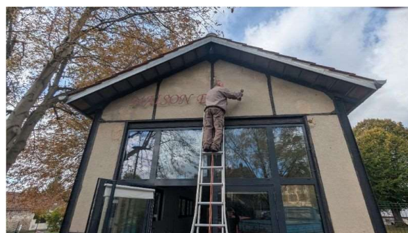
DEMONTAGE DE L'ENSEIGNE
